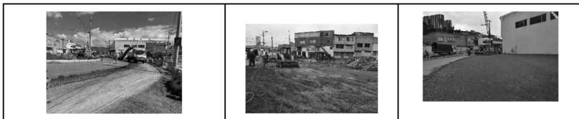
Avances en la construcción de la fase final en la Glorieta Chapal
